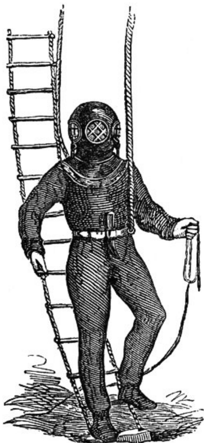
In 1837 combineerde Augustus Siebe als eerste de duikhelm van de gebroeders Deane met een waterdicht rubberen duikpak.
